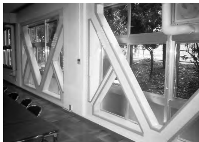
耐震化された久野喜台小学校多目的教室
